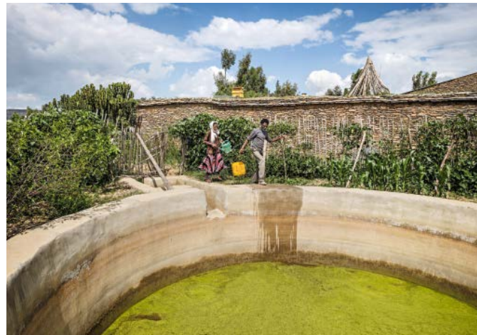
Der Algenteppich im grossen Wasserbecken reduziert die Verdunstung.
